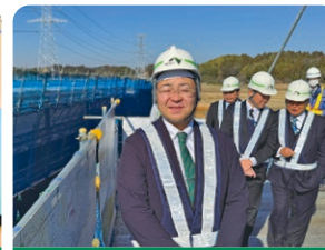
圏央道の多古町・神崎町の工事現場等を視察
